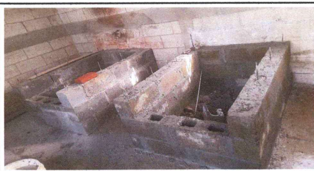
Foto 6: Reparación y construcción de Estufas como parte de la Reparación de Cocina.
