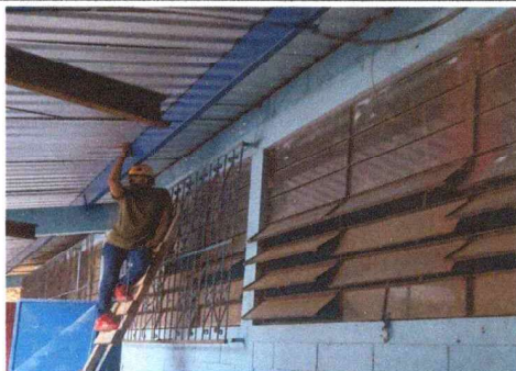
Foto 3: Desinstalación de Vidrios y Balcones en mal estado.
