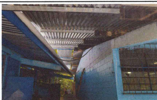
Foto 2: Cubierta de lámina y estructura en proceso de instalación.
