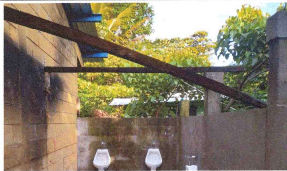
Foto 4: Desinstalación de Cubierta de lámina y estructura de madera en mal estado en servicios sanitarios.
