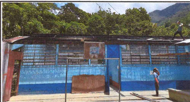
Foto1: Cubierta de lámina en proceso de desinstalación. Módulo 1.
